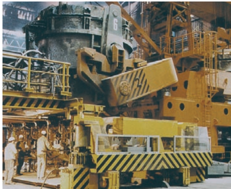
500t Pfannendrehturm mit integrierter Wägetechnik von Schenck Process Austria.
